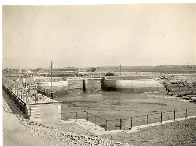
Εικόνα 12: Κατασκευή του Έργου
