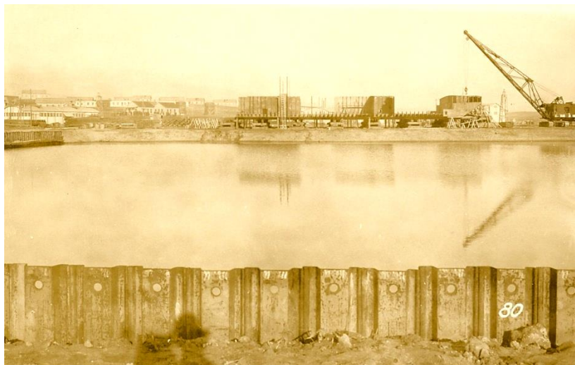
Εικόνα 11: Κατασκευή του Έργου
