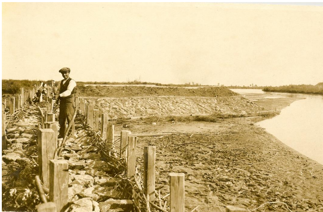
Εικόνα 9: Κατασκευή του Έργου
